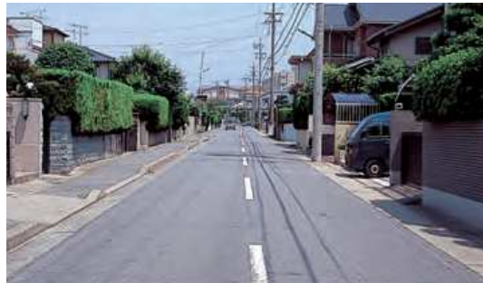
歩道のある道路
